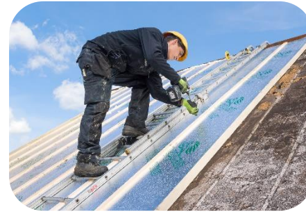
Schuin dakisolatie buitenzijde
