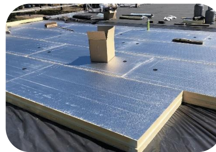
Plat dakisolatie buitenzijde
