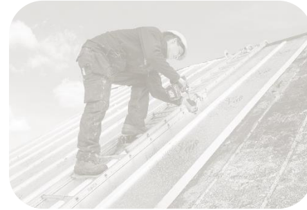
Schuin dakisolatie buitenzijde
