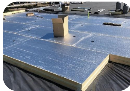
Plat dakisolatie buitenzijde
