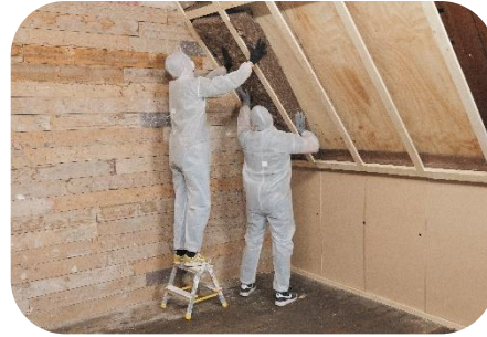
Schuin dakisolatie binnenzijde
