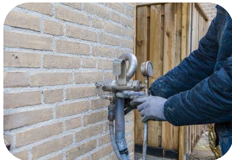
Spouwmuurisolatie
