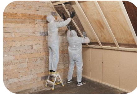
Schuin dakisolatie binnenzijde
