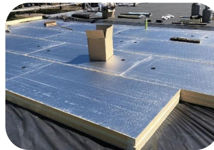
Plat dakisolatie buitenzijde
