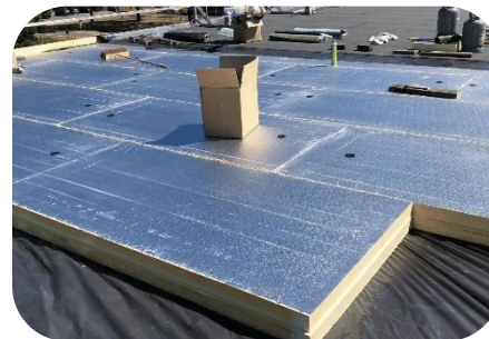
Plat dakisolatie buitenzijde
