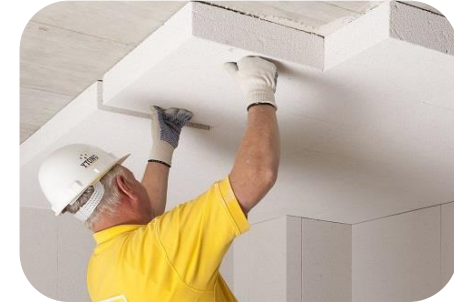
Plat dakisolatie binnenzijde
