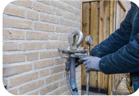
Spouwmuurisolatie
