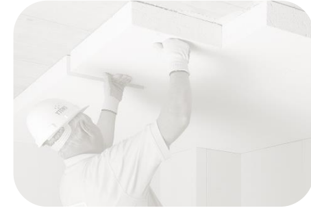
Plat dakisolatie binnenzijde
