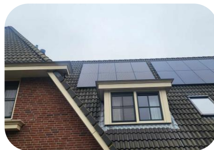
13 zonnepanelen 300 Wattpiek
