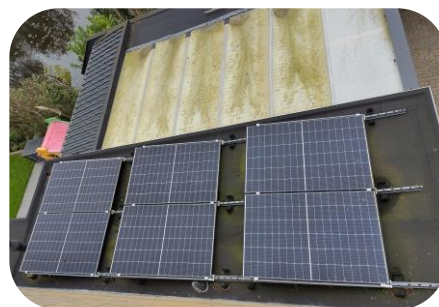
6 zonnepanelen 400 Wattpiek
