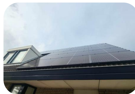
22 zonnepanelen 370 Wattpiek
