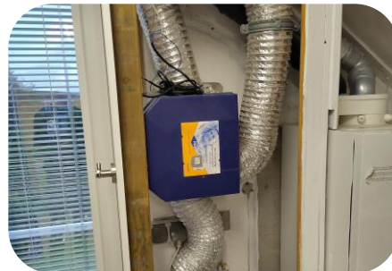
Mech. Ventilatie zonder sturing
