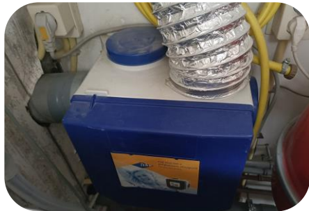
Mech. Ventilatie zonder sturing
