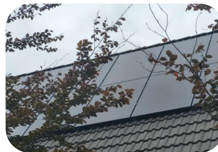
20 zonnepanelen 435 Wattpiek
