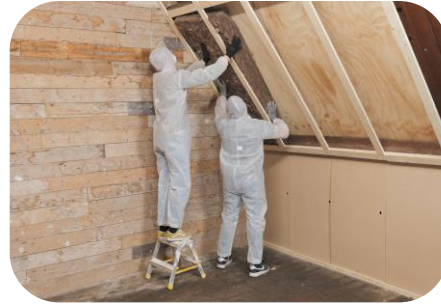
Schuin dakisolatie binnenzijde
