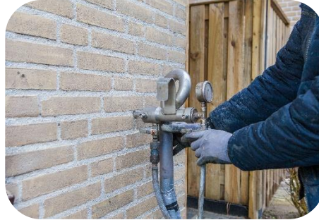
Spouwmuurisolatie
