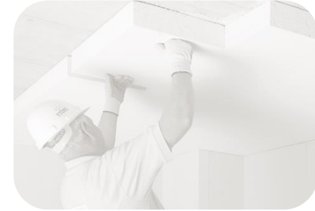
Plat dakisolatie binnenzijde
