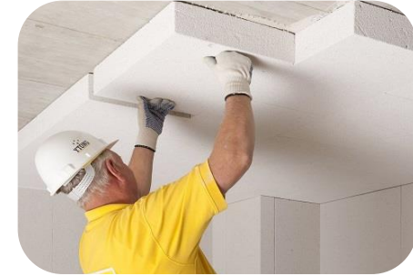
Plat dakisolatie binnenzijde
