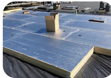
Plat dakisolatie buitenzijde
