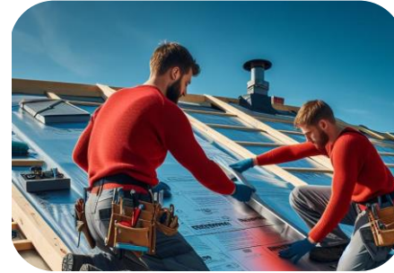
Schuin dakisolatie buitenzijde
