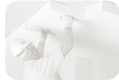
Plat dakisolatie binnenzijde
