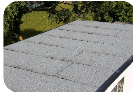
Plat dakisolatie buitenzijde
