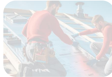
Schuin dakisolatie buitenzijde
