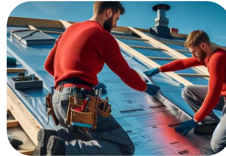
Schuin dakisolatie buitenzijde
