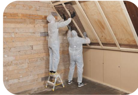
Schuin dakisolatie binnenzijde
