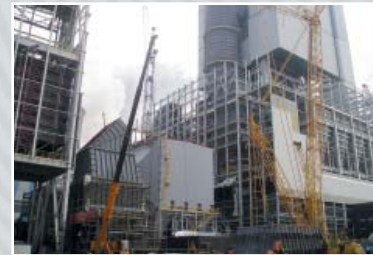
Elektrárna Belchatów, montáž kouřovodů celkové hmotnosti 4,7 tisíce tun potrubí, 2008-10, PL
