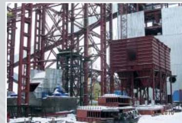
Aksuskij Závod Ferrosplavov, šéfmontáž u uvádění do provozu odprašeni, 2010, KAZ
