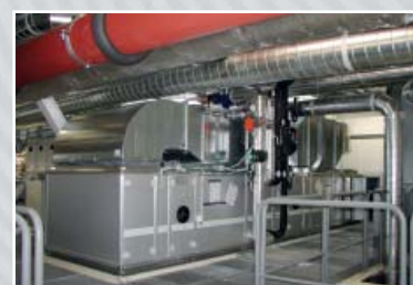
Schwan Cosmetics Český Krumlov, montáž klimatizace a ventilace, 2000, CZ
