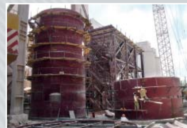
Katavskij cement, šéfmontáž stabilizátoru a elektrického odlučovače, 2008, RU
