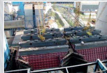
Komplexní obnova elektrárny Tušimice II, CZ, rekonstrukce elektrických odlučovačů a kouřovodů, 2008-11, CZ
