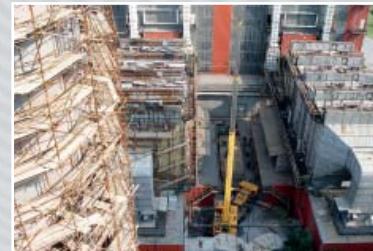
Teplárna Trmice, montáž síla 2000 m 3 , rekonstrukce elektrických odlučovačů a pneumatické dopravy, 2007-8, CZ
