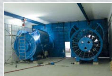
Ventilace metra stanice Prosek, montáž axiálních ventilátorů APE, 2007, CZ
