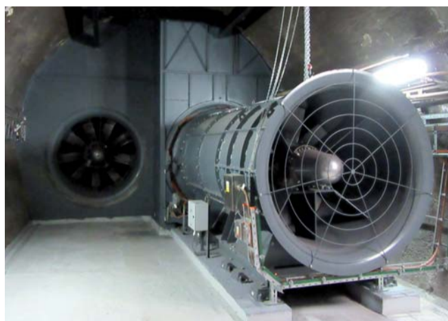
Ventilátor ve větrací šachtě Čelakovského sady.
