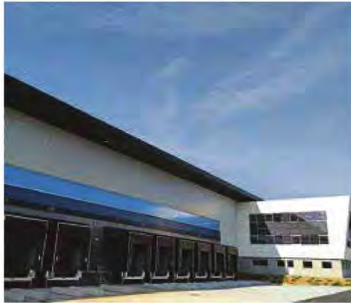
Un nouveau stock central est en cours d'aménagement dans un entrepôt de 15.000 mètres carrés à Saint-Quentin-Fallavier (Isère).
