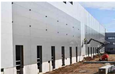
À Mommenheim, FM Logistic construit un nouvel entrepôt de 20 000 m 2 Photo DNA/Michel FRISON
