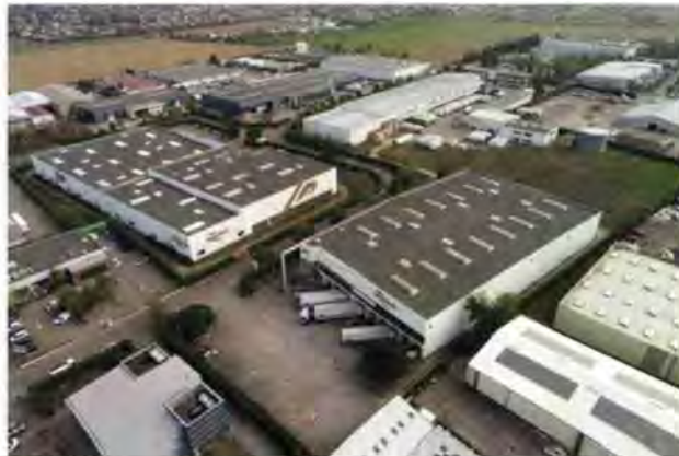
Avec sa plateforme de Saint-Quentin-Fallavier (38) de 20 000 m 2 , le groupe vise le zéro rupture et un taux de commandes complètes livrées à la date prévue de 95 %.
