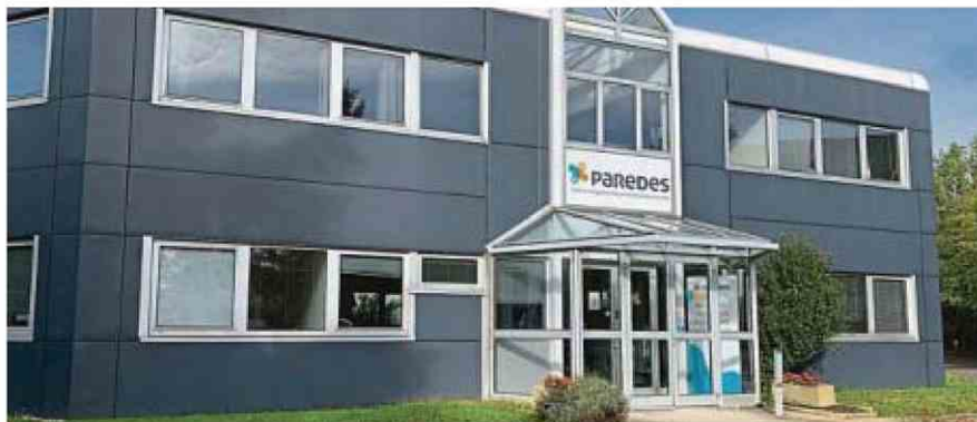
Les nouveaux locaux de Goussainville font écho à la transformation menée à l'échelle nationale par Paredes. Photo Paredes
