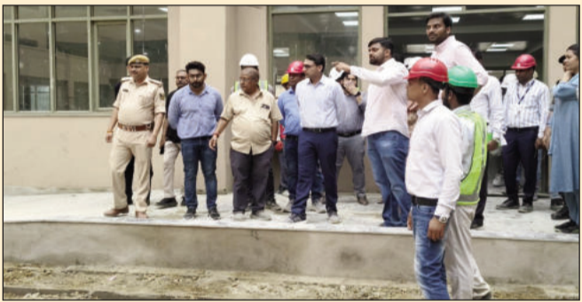
निर्माणधीन मेडिकल कॉलेज का जिलाधिकारी ने किया निरीक्षण।
