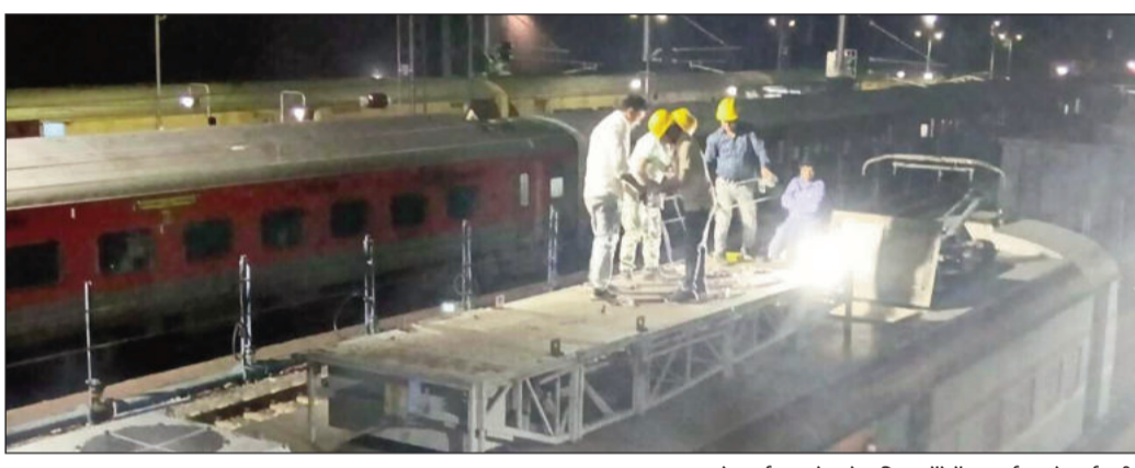
प्लेटफार्म पर ओवरहेड विद्युत मेटेनेस कार्य करते कर्मचारियों।
