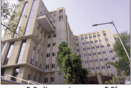
पटना विवि में कला संकाय का नवनिर्मित प्रशासनिक एवं शैक्षणिक भवन।
