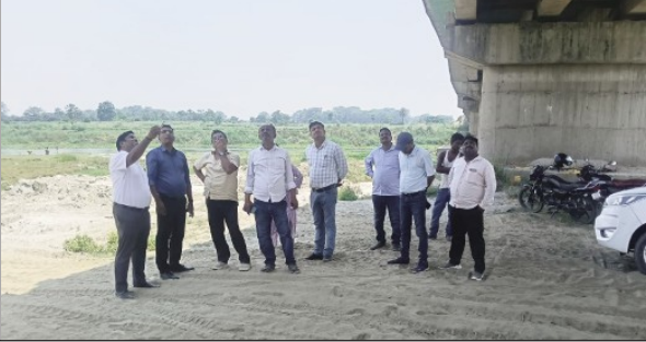
चंदवारा पुल निर्माण कार्य में हुई अनियमितता की जांच को पहुंची पटना की उच्चस्तरीय तकनीकी जांच टीम।
