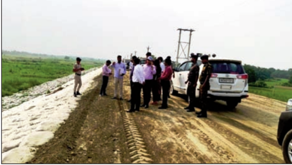
अधिकारियों के साथ औराई में बागमती नदी के तटबंध एवं तटबंध पर चल रहे सड़क निर्माण कार्य का निरीक्षण करते
