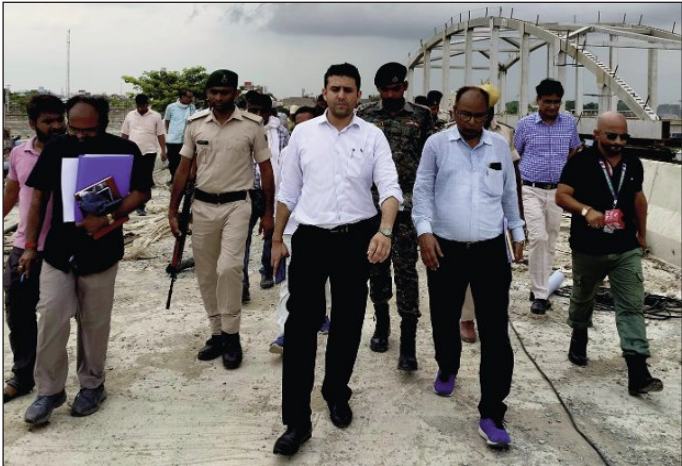
मेहसौल ओवरब्रिज निर्माण स्थल का निरीक्षण करते जिलाधिकारी रिची पाण्डेय।
