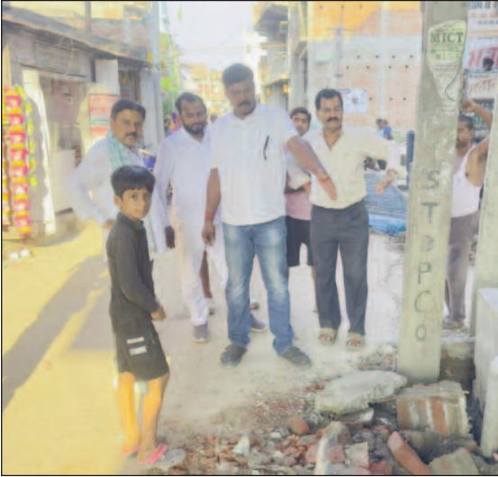
सिंहवाड़ा के भरवाड़ा नगर पंचायत में नाला निर्माण का निरीक्षण करते मुख्य पार्षद एवं अन्य ।
