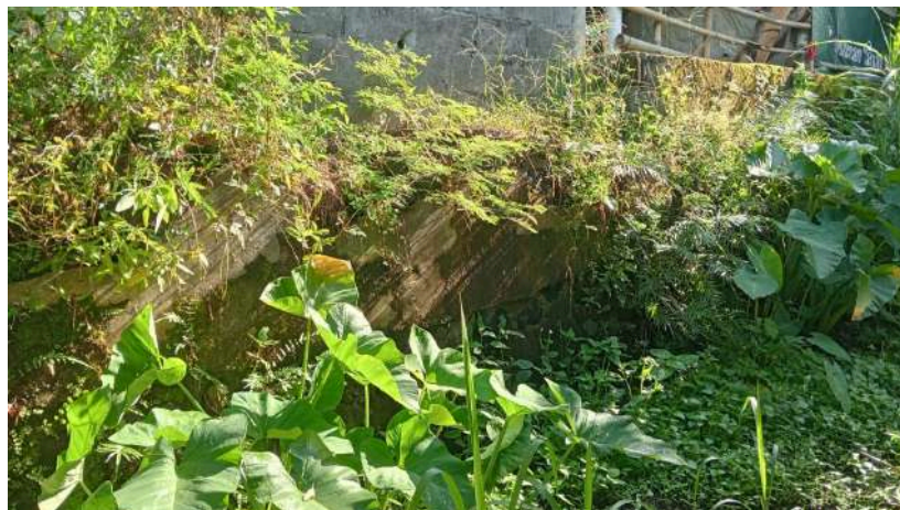
Gambar 39. Bekas Bangunan Kolam Besar di Padukuhan Klelen-Tegalsari
