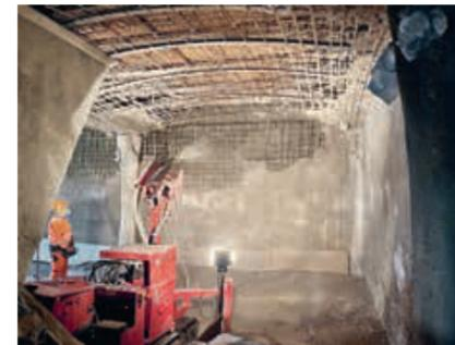
Fig. 1 — Ci-dessus: projection d'un mur en shot-earth
