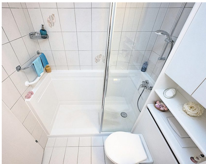
Die nachträglich eingebaute Dusche hat einen rutschfesten Belag. Der Griff auf der richtigen Höhe schützt ebenfalls vor Stürzen.
