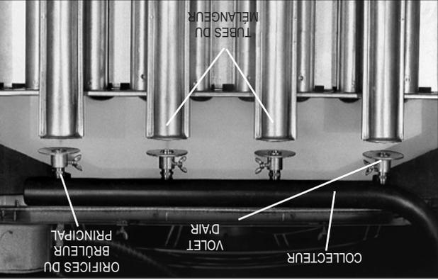
Figure 16.3 - Réglage du volet d'air, propane
