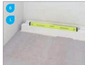
Installatieblok waterpas stellen / Horizontal positioning of the polystyrene installation block / Positionnement horizontal du bloc d'installation / Den Polystor Installationsblock waagrecht ausrichten
