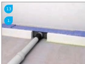
Afvoerbus Ø50mm plaatsen / Connect Ø50mm waste pipe / Mettre le tuyau d'écoulement Ø50mm / Abwasserrohr DN 50 aufstecken
