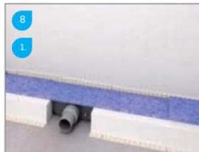
Plaats de drain op de installatieblok / Positioning of the drain in the installation block / Positionnement du drain dans le bloc d'installation / Positionierung der Rinne im Installationsblock
