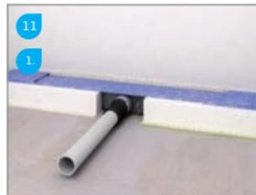
Afvoerbus Ø40mm plaatsen / Connect Ø40mm waste pipe / Mettre le tuyau d'écoulement Ø40mm / Abwasserrohr DN 40 aufstecken
