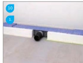
Schuifmoef plaatsen / Install waste connector / Installer le manchon de raccordement / Rohr mit Muffe aufstecken.
