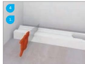
Installatieblok op maat versnijden indien nodig / If necessary cut the polystyrene installation block on the requested dimension / Coupez le bloc d'installation sur la mesure demandée si nécessaire / Schneiden Sie den Polystyrolblock auf das benötigte Rinnenmaß zu.
