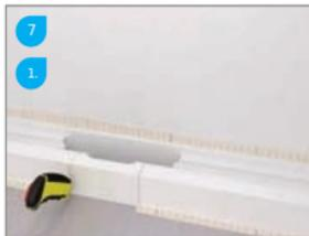
Installatieblok versnijden ter hoogte van de uitlaat / Cut out the part for the waste in the installation block / Coupez le centre du bloc d'installation pour permettre le passage de l'évacuation / Schneiden Sie das Stück für den Anschlussstutzen und die erdungsschärbe aus dem Installationsblock heraus.
