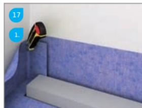
Uitsnijden van het hoekdeel in de waterdichtingsmat / Cutting out the corner part in the waterproofing mat / Découper le tapis imperméable au niveau des coins / Das Eck aus dem Dichtungsvlies ausschneiden
