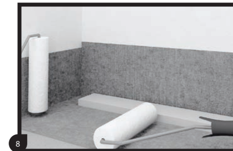
8 Alternatief: u kan ook gebruik maken van een extra waterdichtingsdoek. De mat openvouwen, verkleven tegen muur en vloer. Aanrollen voor een goede hechting. / Alternative: You can also use an extra waterproof membrane. Unfold the waterproof membrane and glue it to the floor and wall. After that, roll it on for a good adhesion. / Alternatif: vous pouvez également utiliser une natte d'étanchéité supplémentaire. Déplier le tapis imperméable et coller sur le sol et les murs. Parfaire le collage à l'aide d'un rouleau. / Alternativ: Sie können auch ein extra wasserdichtes Tuch verwenden. Das Dichtungsvlies ausklappen und mit einer Walze fest an den Kiebel andrücken.
