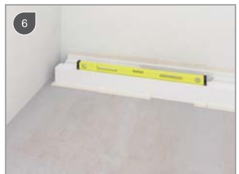
Installatieblok waterpas stellen / Horizontal positioning of the polystyrene installation block / Positionnement horizontal du bloc d'installation / Den Polystor Installationsblock waagrecht ausrichten
