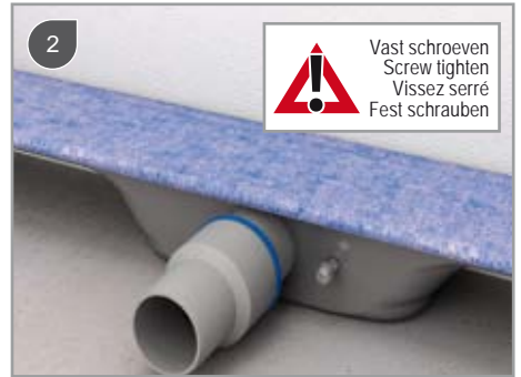
Het buitenschroefdeel op het binnenschroefdeel schroeven / Screw the outer screw part on the inner screw part / Visser la sortie sur le filetage prévu a cet effet/Den aussenliegenden Schraubstutzen fest auf den innenliegenden aufdrehen
