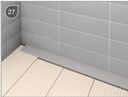
Tegellijm (EN 12004 C2) uitstrooien / Spread of the tile adhesive (EN 12004 C2) / Appliquer de la colle à carrelage (EN 12004 C2) / In der Duschfläche auf das Dichtungsvlies Flexkleber aufziehen
