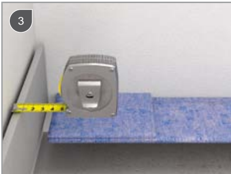
Meten van de tegeldikte* / Measurement of the tile thickness* / Mesurer l'épaisseur du carrelage* / Die Fliesenstärke messen*
