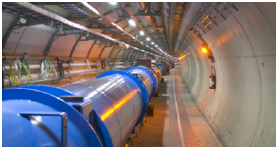
Figure 1 : aimants supraconducteurs (NbTi à 1,9 K) du LHC dans le tunnel du CERN (photo CERN).
