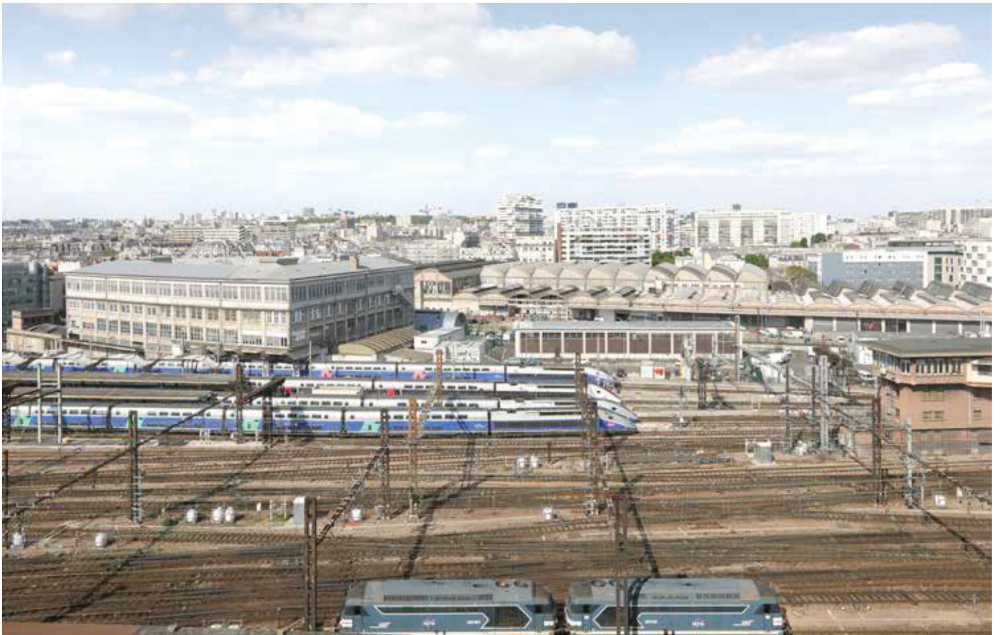
Le site Messageries se trouve entre la rue de Rambouillet au nord-ouest, les rues du Charolais et Jorge Semprún au nord-est et le faisceau de rails de la gare de Lyon au sud-ouest.
