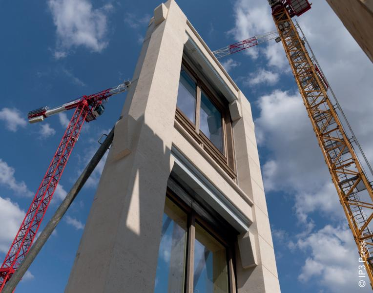
Réalisés à taille réelle, les prototypes sur le chantier de l'immeuble Messenger permettent de s'assurer de la qualité des matériaux, de la cohérence de la conception et de la bonne exécution des façades.
