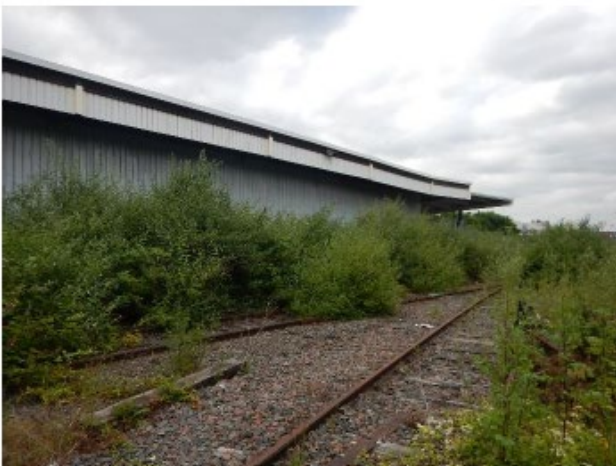
Gravats et ballasts
