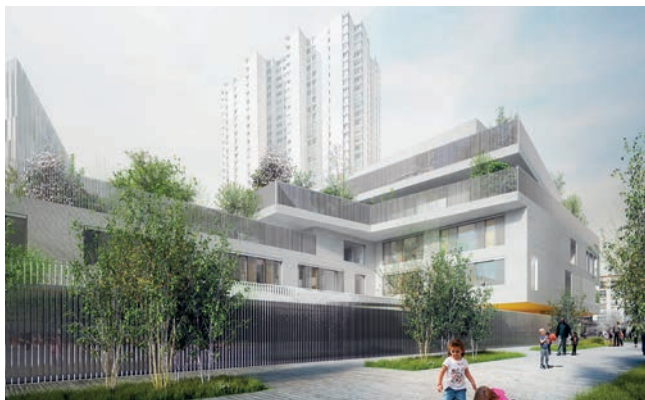
© Ville de Paris, TOA Architectes Associés
