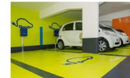
Places de recharge pour voitures électriques - Toulouse/Avignon
