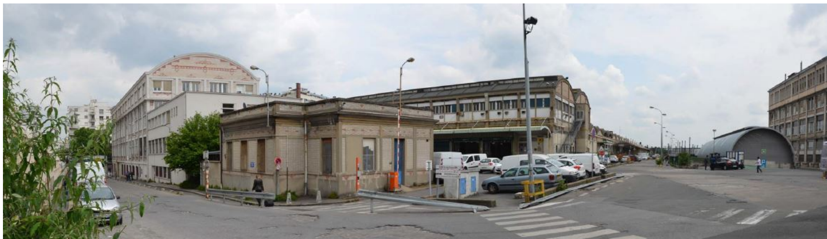
Halle Charolais et ancien bâtiment de télégraphe
