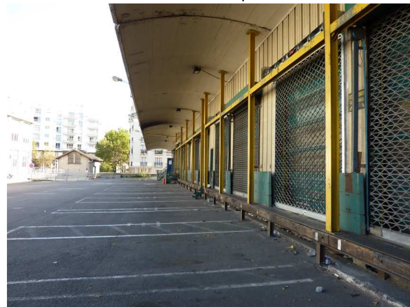
Vue actuelle des espaces extérieurs vacants
