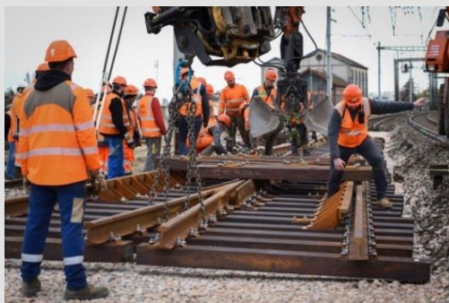
Renouvellement d'aiguillage
