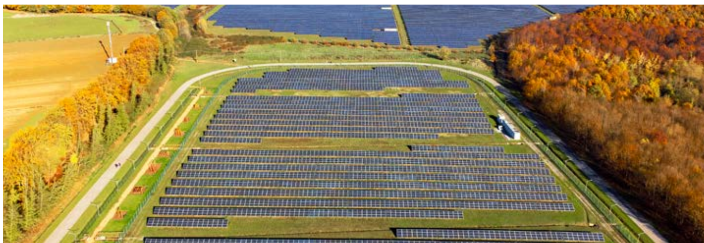
Parco fotovoltaico di Cavriglia
