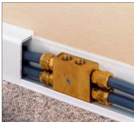
40. Colombusæg for tilslutning af kedel / unit.
