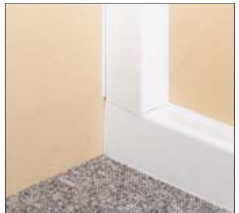
32. Montering af panel i hjørne.
