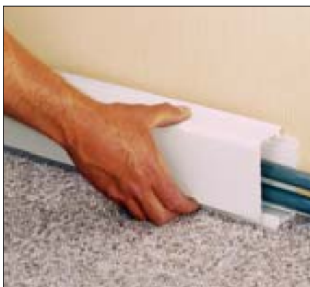
25. Front-panelet trykkes let på plads. Forbindelse øverst og nederst skal ske samtidig.
