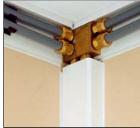
42. Colombusæg monteret i hjørne ved loft.
