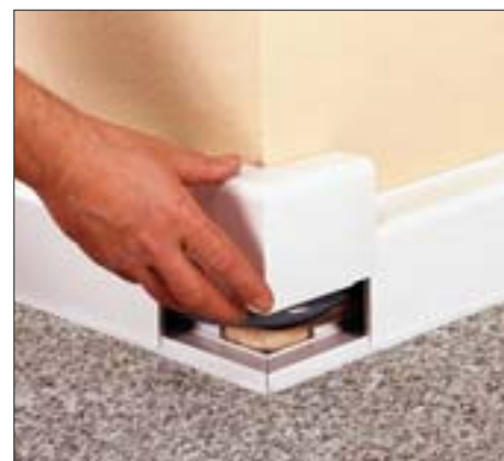
26. Det udvendige hjørne trykkes let på plads i det vægmonterede front-panel.
