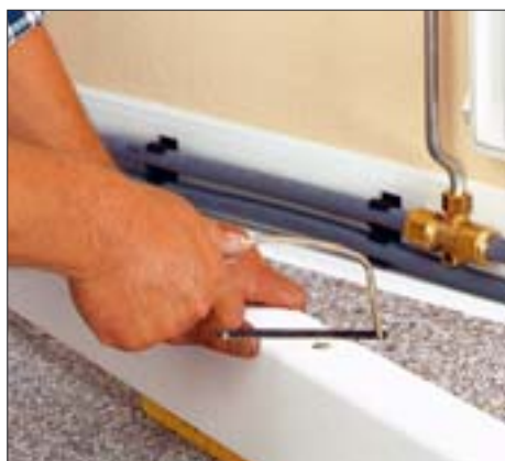
24. Udsækning til stålør-sæt bores og saves.
