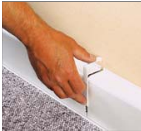
28. Hvor front-panel samles anvendes forbindelsesstykke. Afstand mellem front-panelerne skal være 5 - 8 mm.
