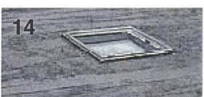
Vådrums tætningsmasse korrekt udlagt
