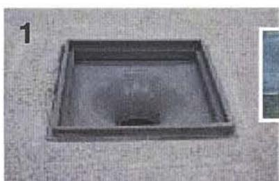
Afløbet med MaxiFlex forhøjelsesramme, korrekt monteret, jvnf. fabrikantens anvisning.
