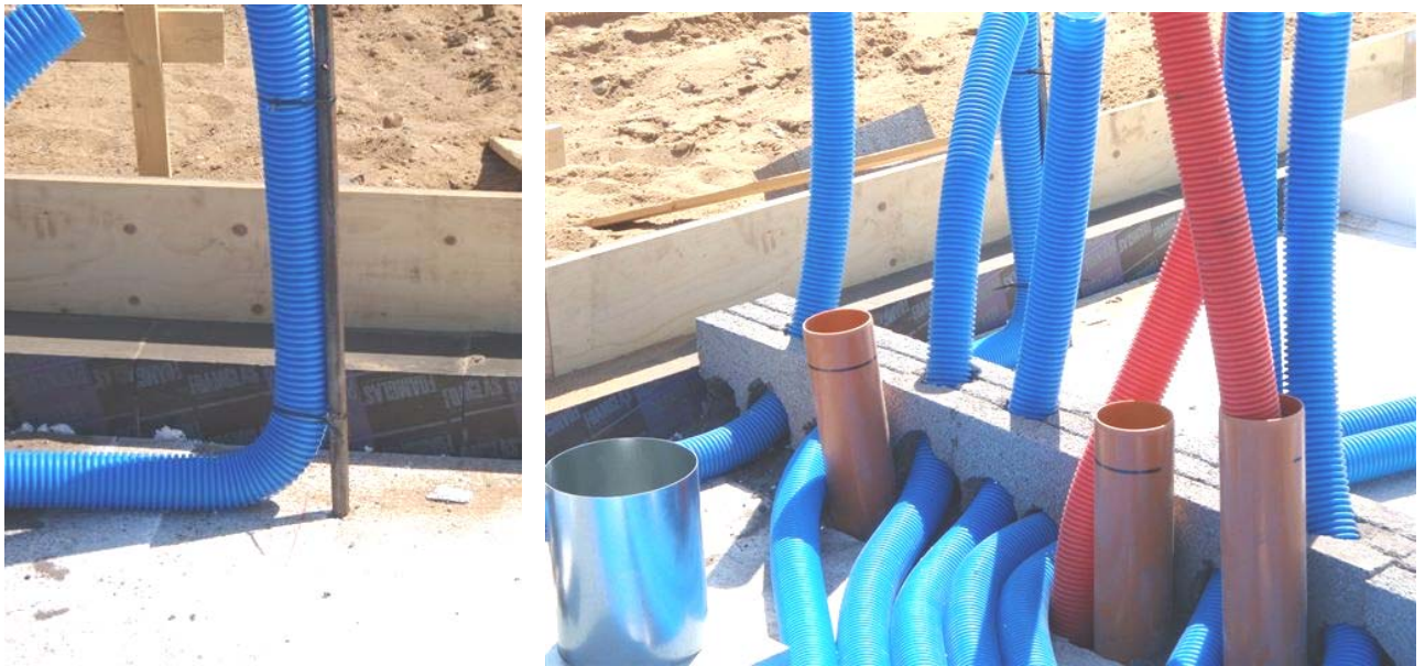
Figur 6: Montagemetoder når slanger skal føres videre i væg.
