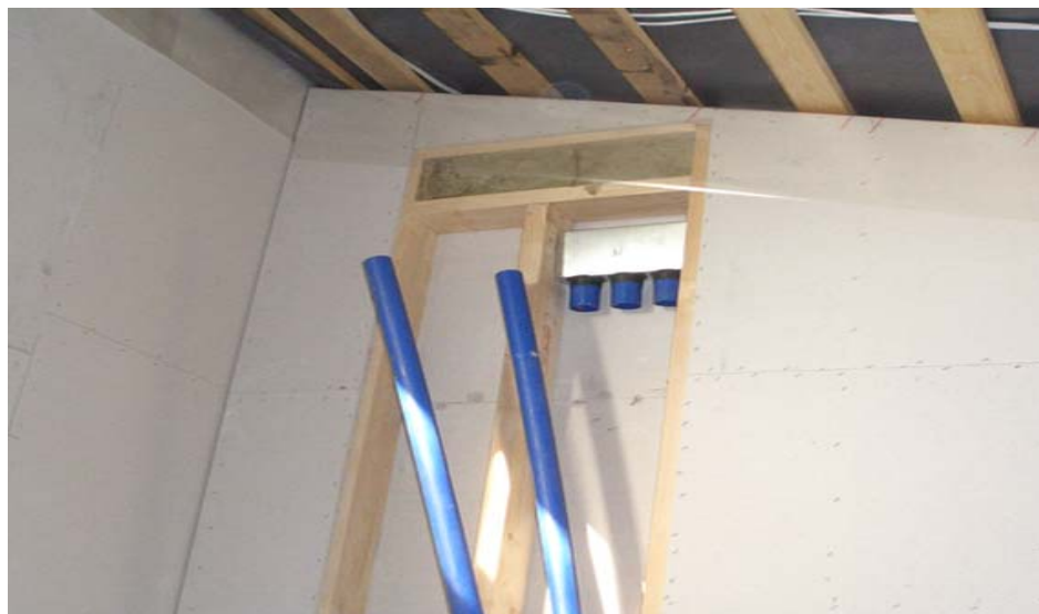
Figur 9: Ventil boks som vægmontage
