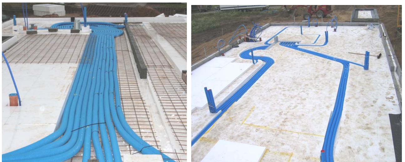
Figur 7: Trækning af Slanger.
