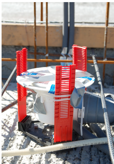
Exempel på montage av golvbrunn på filigranbjälklag med JAFO Golvbrunnfixtur ▼
