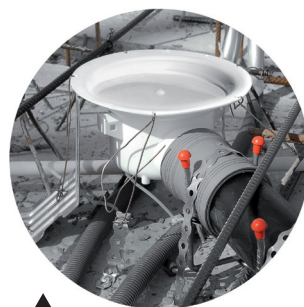
Exempel på montering av golvbrunn UTAN JAFO Golvbrunnfixtur
