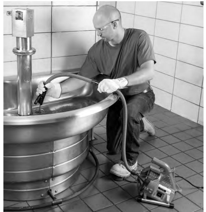
Figure 11 – Récupération du câble
