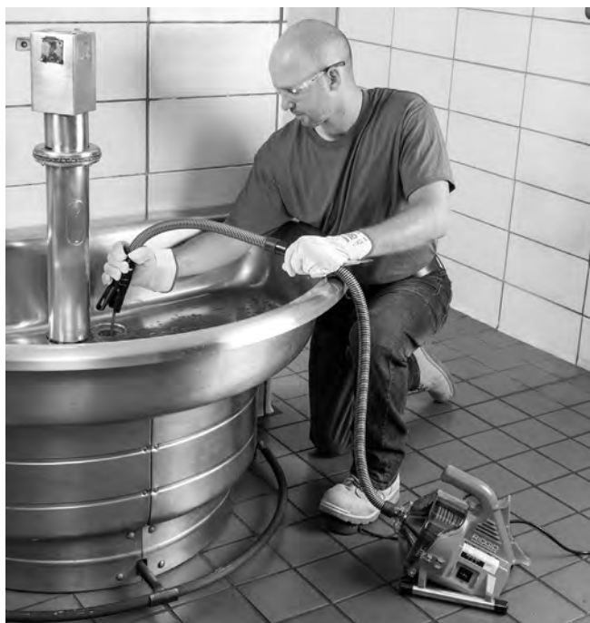
Figura 11 – Recupero del Cavo
