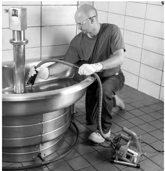
11. ábra – A kábel kihúzása
