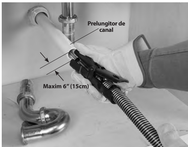
Figura 7 – Exemplu de scurgere prelungită la 6" (15 cm) de unitatea AUTOFEED.
