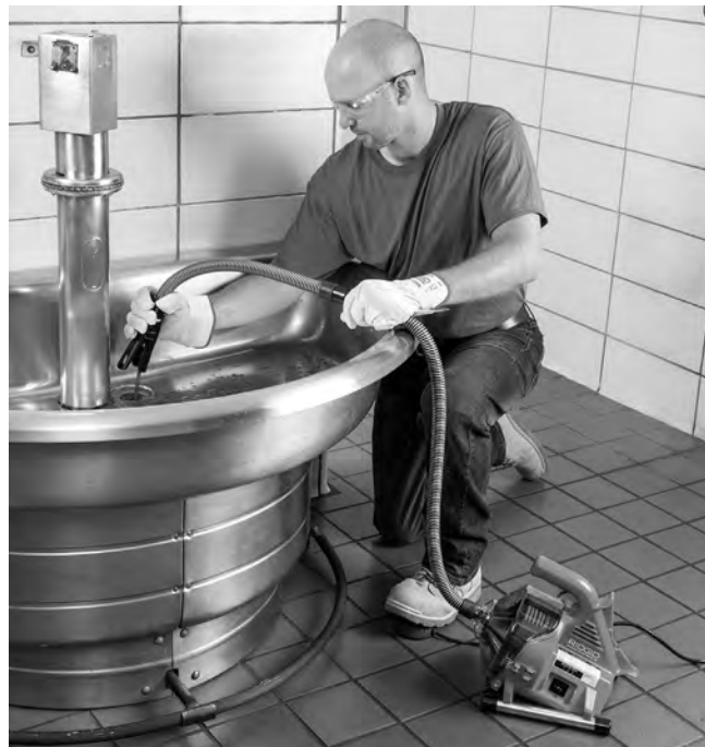
Slika 11 – Izvlak kabla
