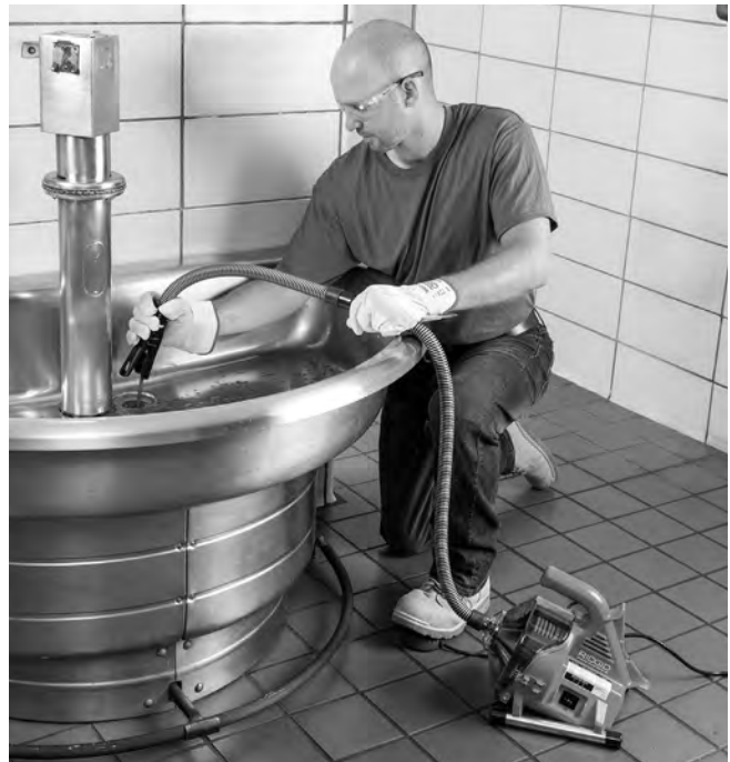
Figur 11 – Trekke ut kabelen
