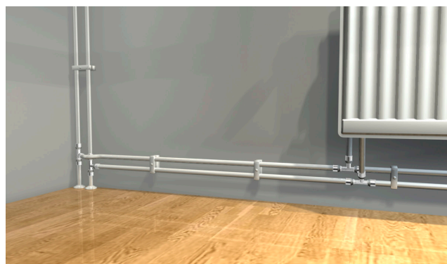
Exempel klamring med synligt montage.
