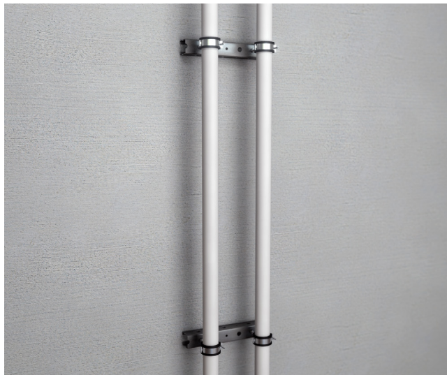
Exempel klamring vid vertikalt montage.
