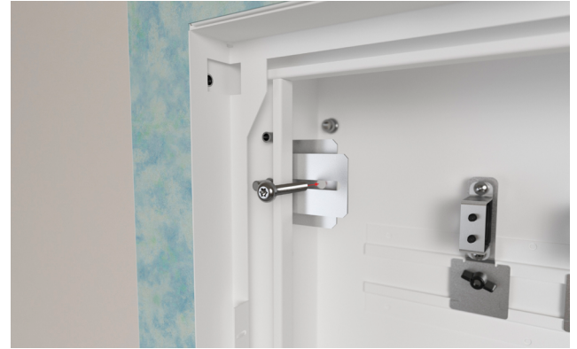
Våtzonsluckan monteras i skåpet.
