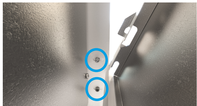
Montering av den kaklingsbara ramen.
