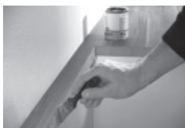
Trin 2: Forsegl de udskårne kanter med en primer.
