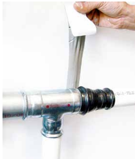
Fig. 35 - Beskyttelse af tilslutninger med butanoltape.
