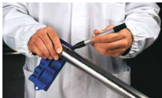
Fig. 28 - Markering af indstiksdybde
