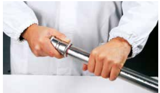
Fig. 31 - Indføring af rør i presfitting
