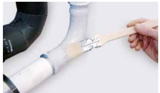
Fig. 34 - Lakering af rør og tilslutninger med grunder.
