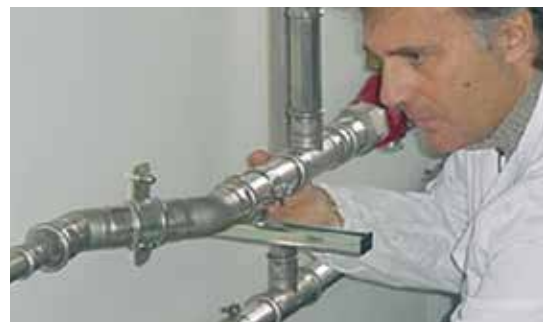
Fig. 33 - Kontrol af pressamling
