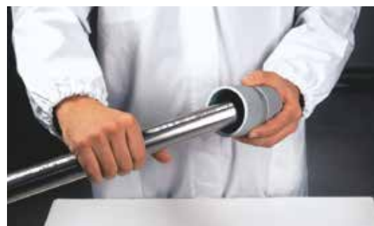
Fig. 26 - Afgratning af rør
