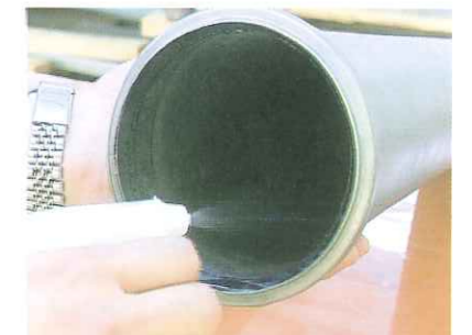
3. Smør tætningsringen med ACO PIPE® glidemiddel og saml rørene
