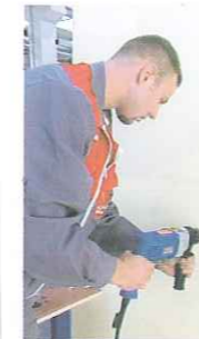
1. Klargør væggen til montering af rørbøjle
