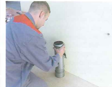
4. Skub ACO PIPE® ind i det allerede installerede rør
