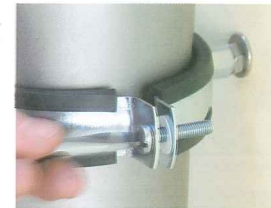
5. Fastgør røret til væggen
