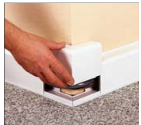
26. Det udvendige hjørne trykkes let på plads i det vægmonterede front-panel.
