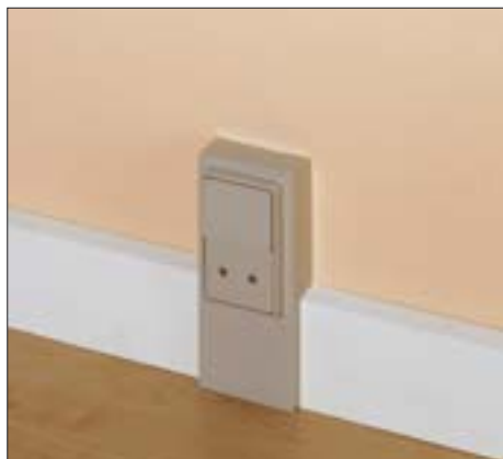
34. Eksisterende stikkontakt i fodliste.
