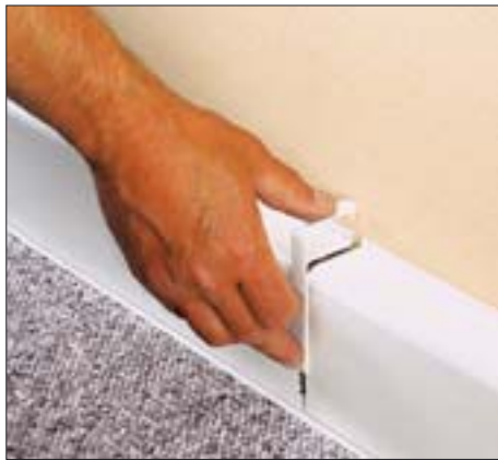
28. Hvor front-panel samles anvendes forbindelsesstykke. Afstand mellem front-panelerne skal være 5 - 8 mm.
