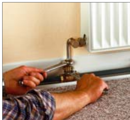
12. Glidemiddel påføres. Fastspænd tilslutningen til radiatoren. Benyt den rigtige nøglestørrelse, og hold kontra.
