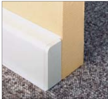
29. Enden på front-panelet afsluttes ved hjælp af et venstre eller højre endestykke. På billedet ses et højre endestykke.
