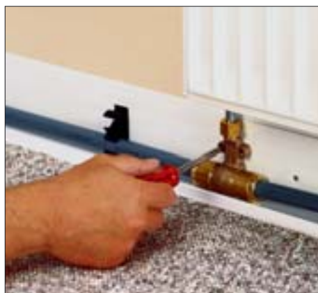
13. Panel-armaturet skrues fast på rørpanelet med medfølgende selvskærende skruer.
