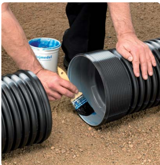
3. Muffen smörjs invändigt med smörjmedel.
