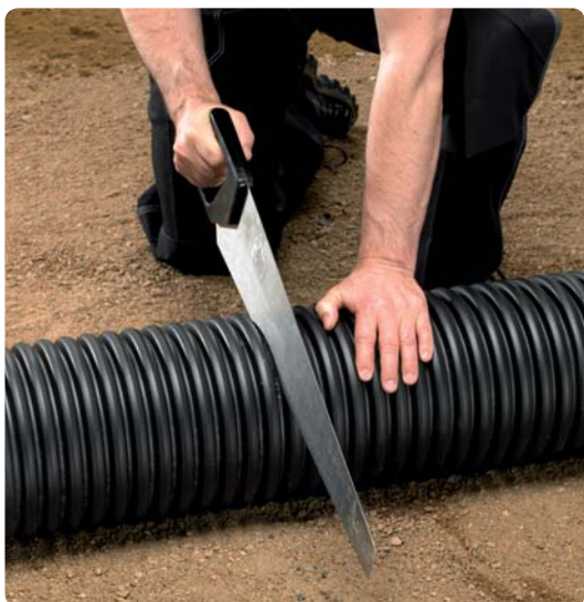
1. Röret sågas av mellan 2 ribbor med fogsvans.
