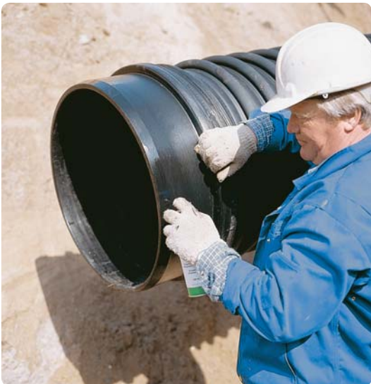
3. Stryk smörjmedel på rörets spetsända.
