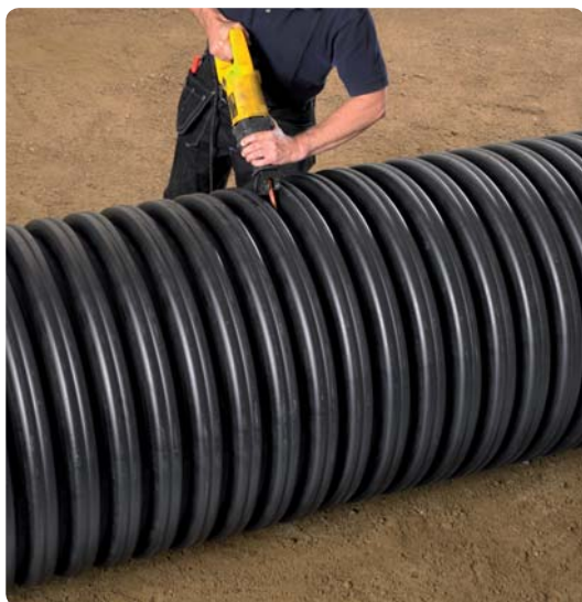
1. Röret kapas mellan 2 ribbor med t ex tigersåg.
