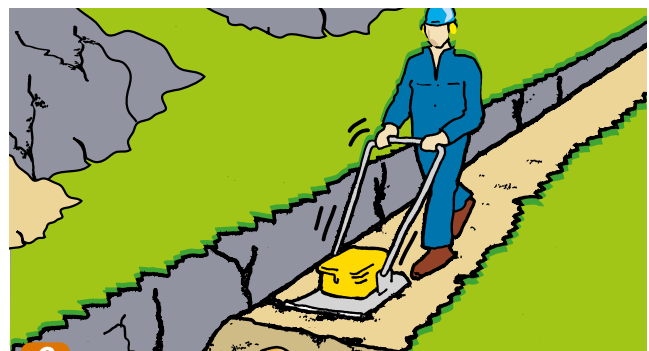
6 Resterande fyllning skall utföras så att konstruktionen ovan ledningen uppfylls.
