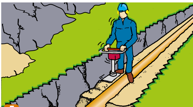
5 Kringfyllningen skall utföras enligt AMA, upp över rören så att en korrekt sidostöttning uppnås för att begränsa deformationen till den önskade.
