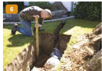
6: Sand fyldes omkring BIO-BLOK® regnvandsfaskinen og stemples godt ned langs siderne for at undgå senere sætninger i terrænet. Hvis pladsen er trang, brug evt. en lægte, et bræt eller tilsvarende.
