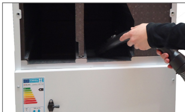
4. Det er en god idé at støvsuge filterkamrene for evt. snavs, der kan forekomme
