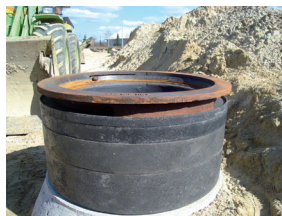
Ø600 brønd forhøjet med topringe og flydende karm.
