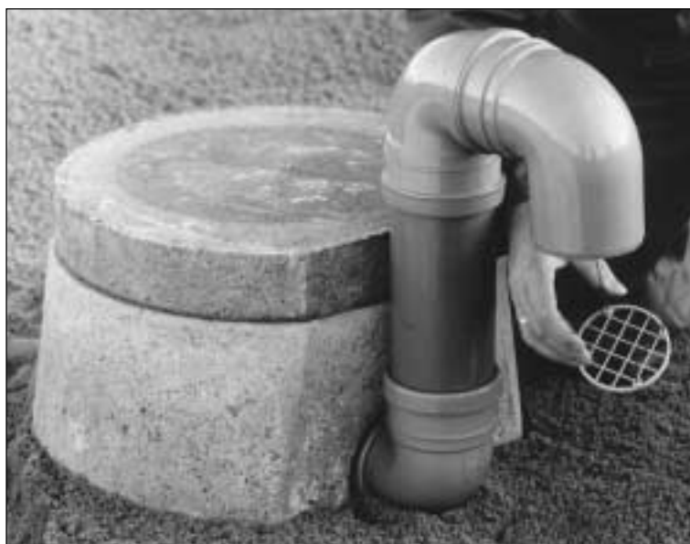
Fig. 19. Eksempel på udformning af udluftning af bundfældningstank eller fordelerbrønd
